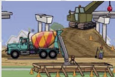
Sa radovima na betoniranju treba da se otpočne, tek nakon što se preduzmu odgovarajuće mjere zaštite i zdravlja na radu od opasnosti od privremene lomljivosti ili nestabilnosti konstrukcije i nakon što lice odgovorno za tu vrstu radova provjeri da li je noseća skela propisno izrađena i da li su izvršeni svi potrebni prethodni radovi.
